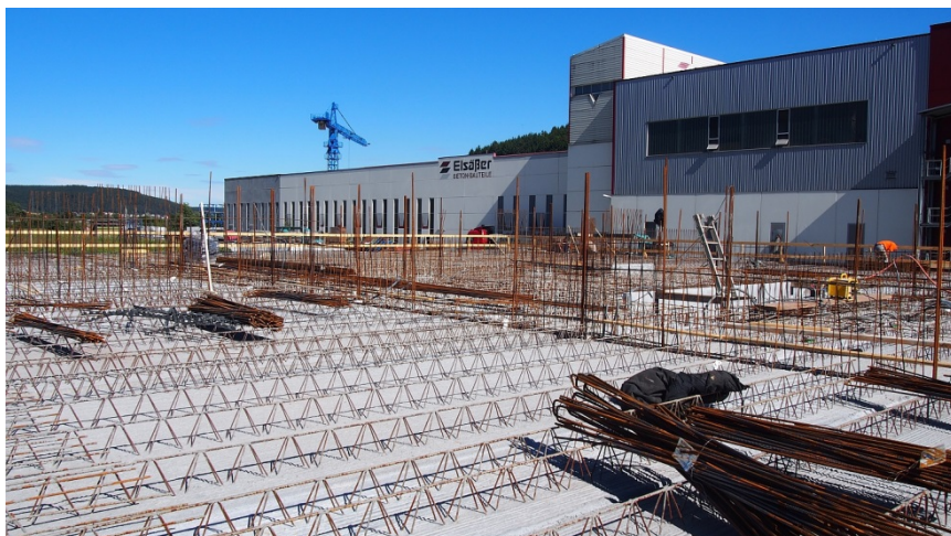
Impression aus der Bauphase
