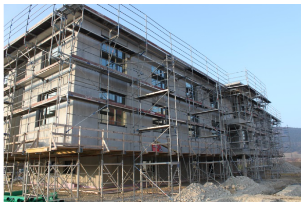
Der weitgehend fertige Rohbau.
