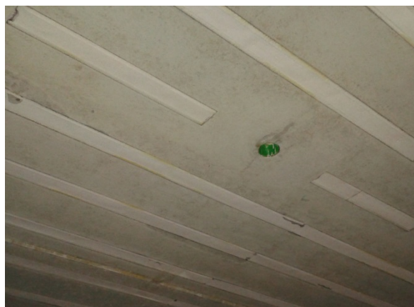
Deckenuntersicht mit Absorberstreifen vor dem Putzauftrag.
