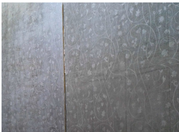
Betonfertigteile mit Reliefstruktur.
