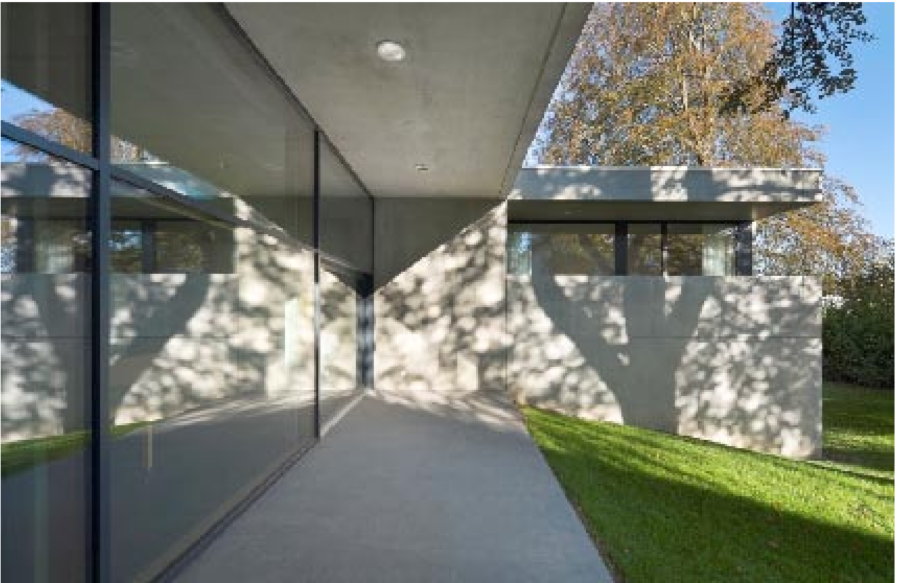
Architektenhaus in Kempten mit SySpro-Thermowand, Hermann Rudolph Baustoffwerk GmbH Foto: Rainer Retzlaff
