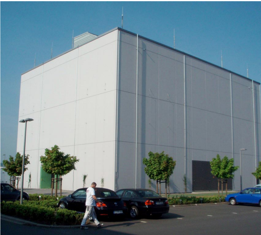
Fertigstellung des abhörsicheren Rechenzentrums mit integriertem Blitzschutz
