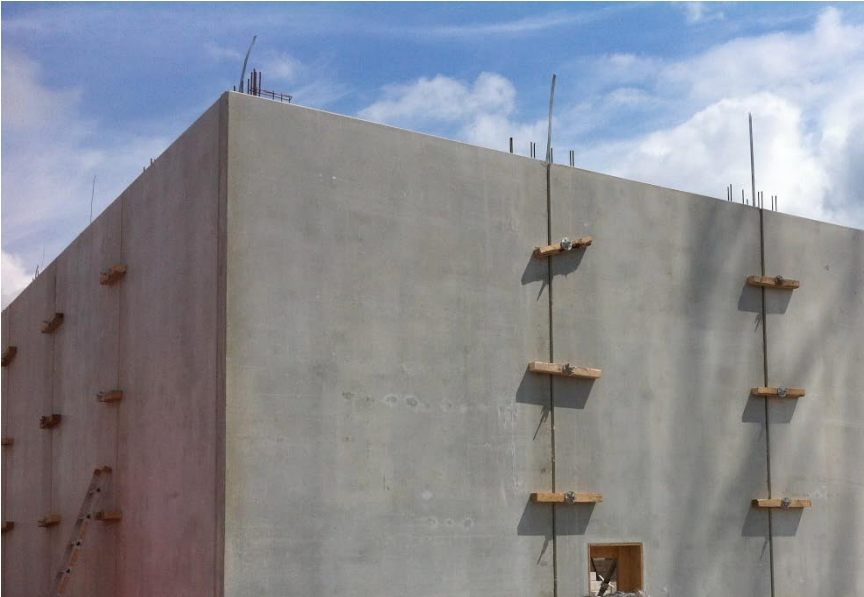
Montagezustand mit Blitzableiter über der Thermowand
