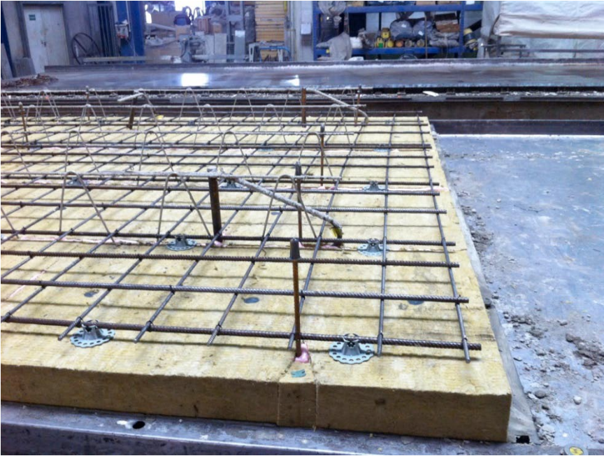
Einbau Dämmung (Steinwollplatten) und Bewehrung (im Kernbeton)
