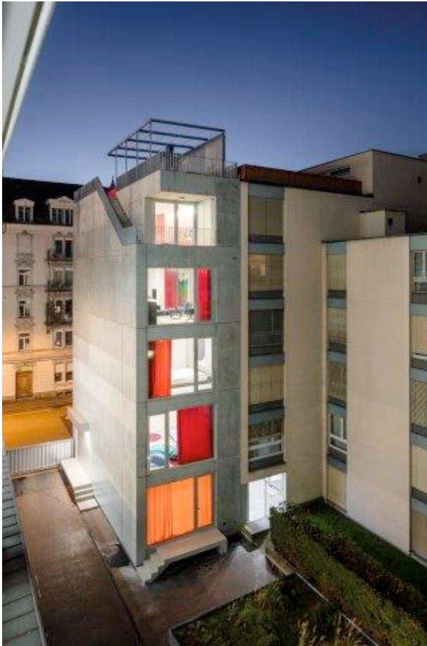
Bewusst kostengünstig geplante Nachverdichtung in Zürich mit vorgefertigten Betonelementen.
