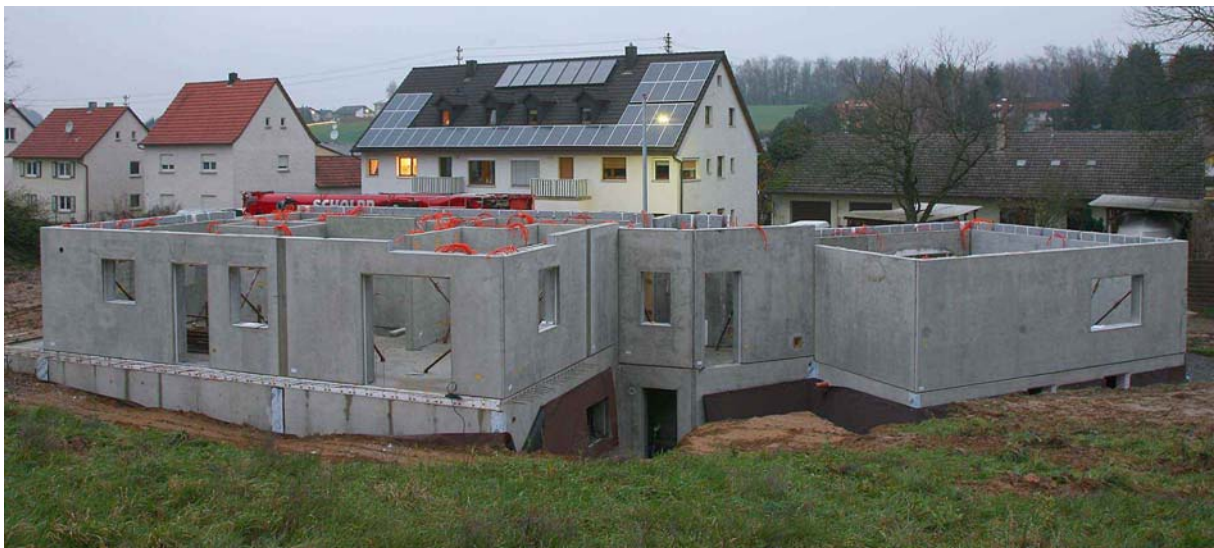
Bild 3: Musterprojekt mit Ökobeton-Fertigteilen in Kirchartd
