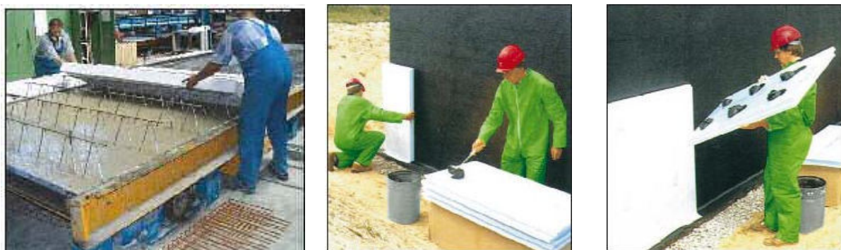
Bild 6: Vergleich des Aufwands für Dämmarbeiten – links: Sicher und schnell in der Werksvorfertigung; Mitte und rechts: Verschiedene handwerkliche Arbeitsgänge auf der Baustelle. Fotos: Syspro [5]
