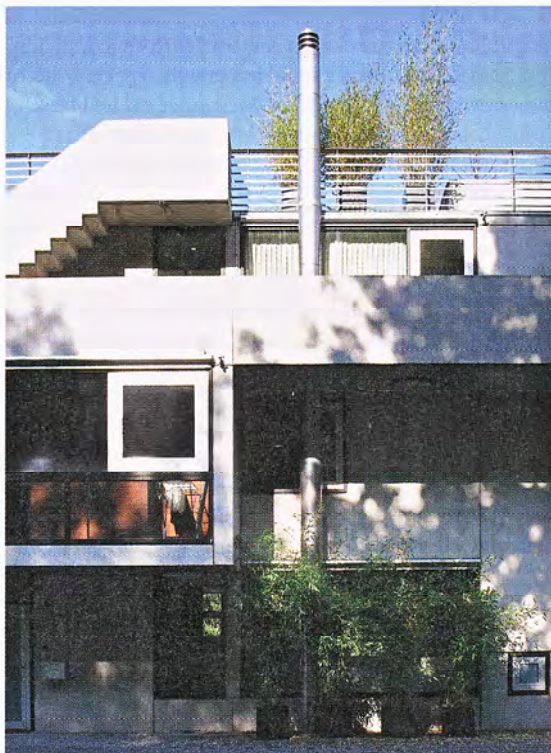
Abb. 2 Wohnhaus mit Thermowänden, entworfen von Felix Oesch, Zürich.
