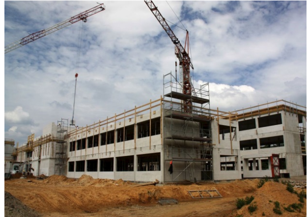
Pro Woche wurden zwei bis drei Bürogeschosse montiert.
