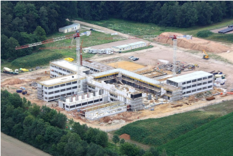
Das Technologie- und Forschungszentrum im Bauzustand. Alle Fotos: Syspro/Ragano
