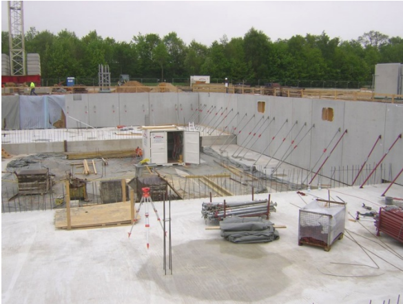
Beim Keller kamen Doppelwandelemente zum Einsatz.
