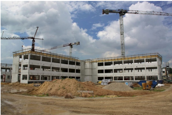
Dank Elementgewichten von höchstens 2,5 t konnte die Montage mittels Baustellenkran erfolgen.
