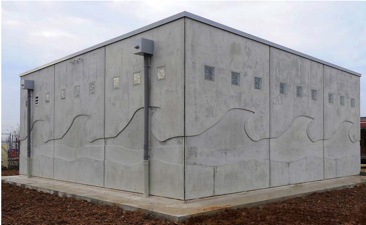
Pumpenstation mit Wellenmotiv in der Sichtbetonfassade.
