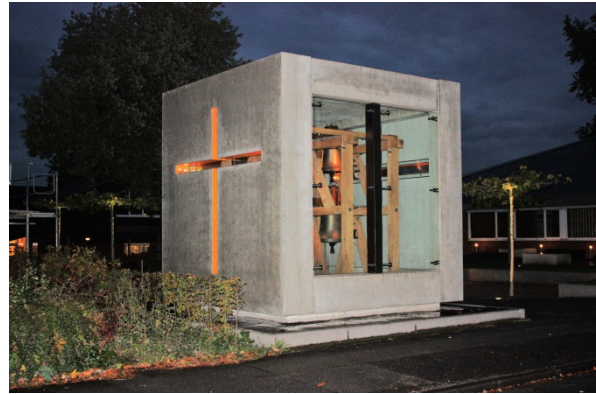
Eine Verbundglasscheibe eröffnet den Blick auf die Mechanik des Glockenstuhls.
