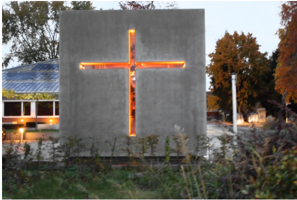
Das neue Glockenhaus ist ein Sichtbetonwürfel mit 3,50 m Kantenlänge. Fotos: Syspro/Lütkenhaus
