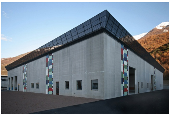
Das Produktionsgebäude der Firma Essepi hat einen Heizenergiebedarf unter 50 kWh/m 2 a. Umbauter Raum: 32.000 m 3 , Nutzfläche: 3.800 m 2 .
