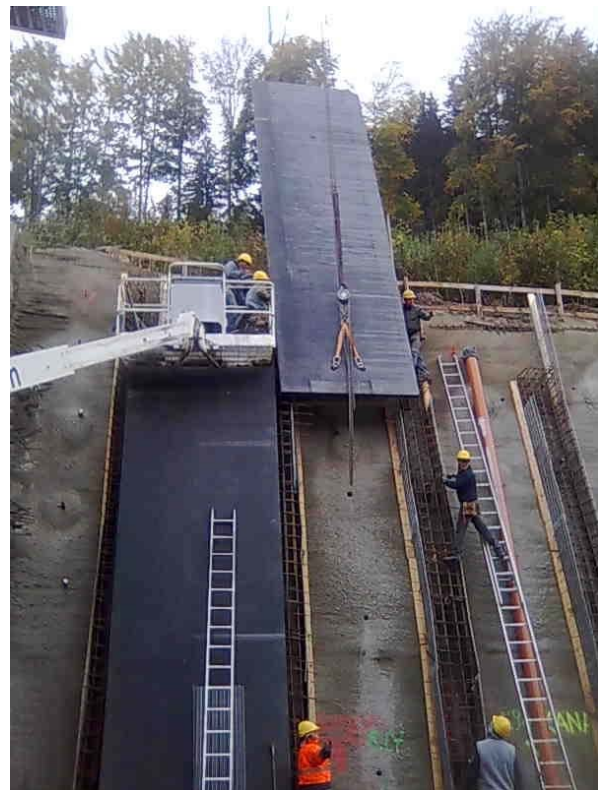
Die Elemente werden zwischen die vorbereiteten Lisenen „eingefädelt“.
