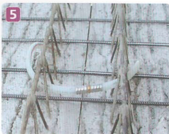
Auf der Baustelle werden die Rohrenden der einzelnen Contec ON Module dann nur noch mittels der unlösbaren Uponor Presstechnik zu Modulgruppen verbunden und an das Versorgungsnetz angeschlossen
