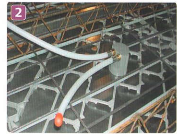
Neben den thermischen Steckdosen Contec TS von Uonor für der Anschluss zusätzlicher Kühlseglern können auch Komponenten anderer Gewerke wie Elektro und Sprinkler in die Elemente integriert werden
