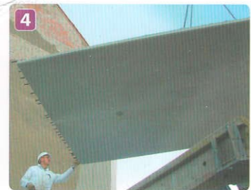
Anlieferung der thermisch aktiven Beton-elemente auf die Baustelle
