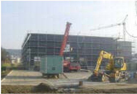
Montage der Fassadenelemente am Pro-Solar-Haus in Ravensburg. Eben noch im Rohbau...
