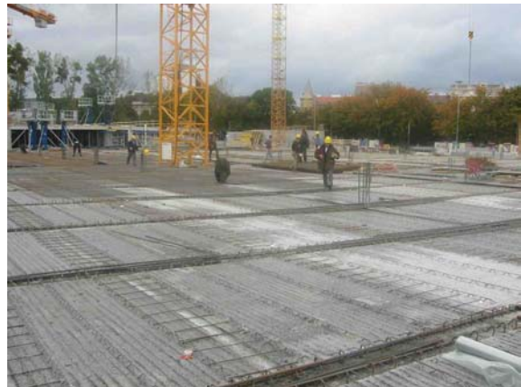
Allein für das Parkhaus West müssen in einem Zeitraum von weniger als drei Monaten rund 30.000 m 2 Elementdecken geliefert werden.
