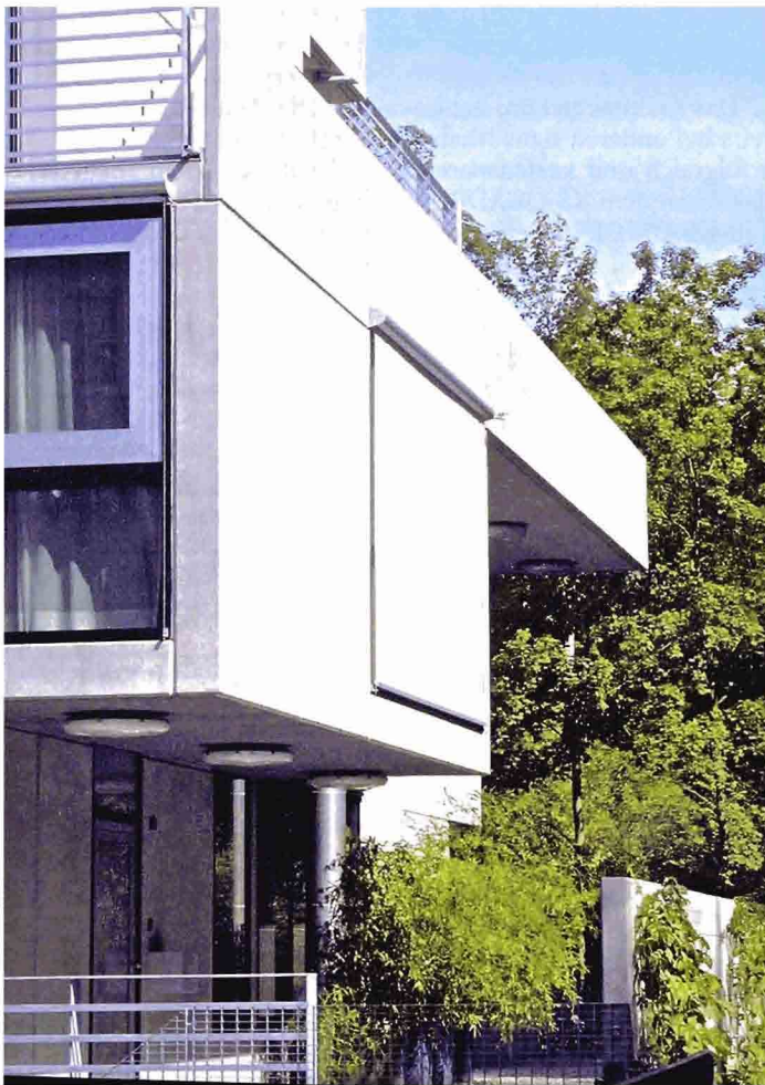
Passivhaus mit Thermowänden in eleganter Sichtbetonausführung
