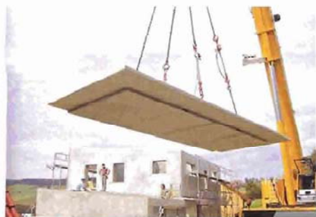
Montage eines Deckenelements
