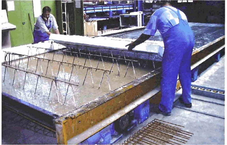
Abb. 2: Produktion von Thermowänden im Fertigteilverk: Einlegen der Dämmschicht
