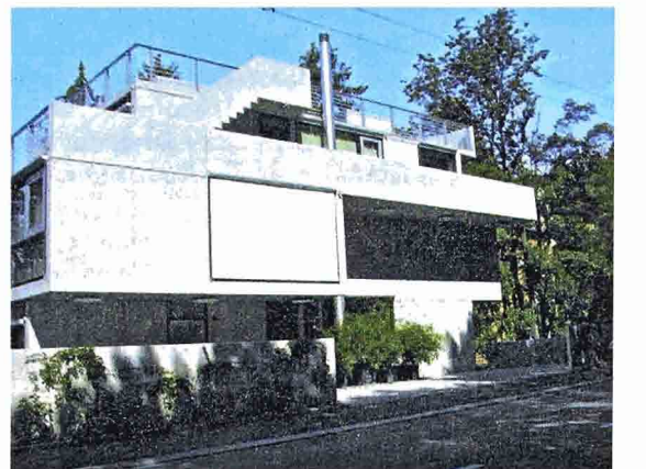
Abb. 2a/b Passivhaus mit Thermowänden in Sichtbetonausführung.
