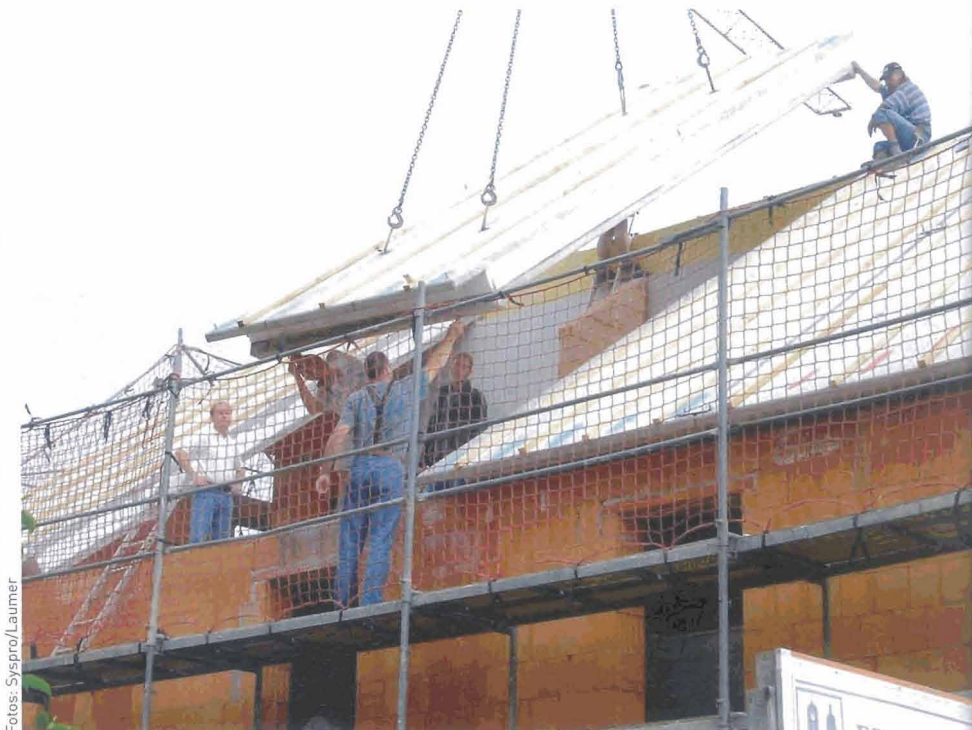
Einfamilienhaus in Erding. Montage der Dachelemente mit vormontierter Lattung.
