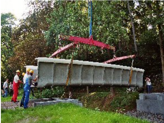
Montage der 5 t leichten Wegebrücke auf dem Oschatzer Landesgartenschau Gelände über das Flüsschen Döllnitz.
