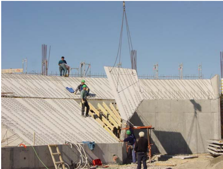
Montage der Deckenplatten auf dem Lehrgerüst.
