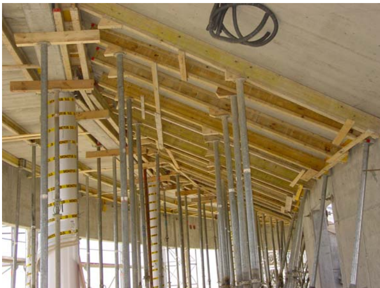
Innenansicht des Rundbaus mit Unterstützungen für die Montage- und Betonierphase der Tribüne.
