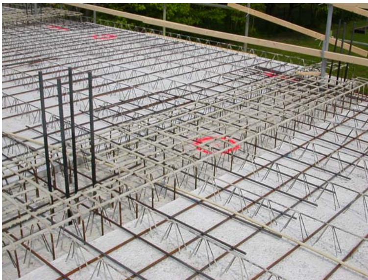
Detail: Streifenförmig verstärkte Bewehrung.
