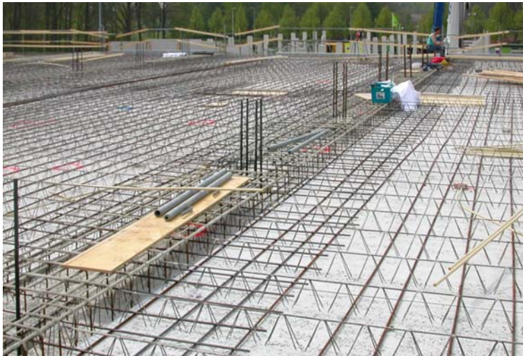
Gebäudeachse: Verlegte Elementdecken und Stützen-Anschlussbewehrung.
