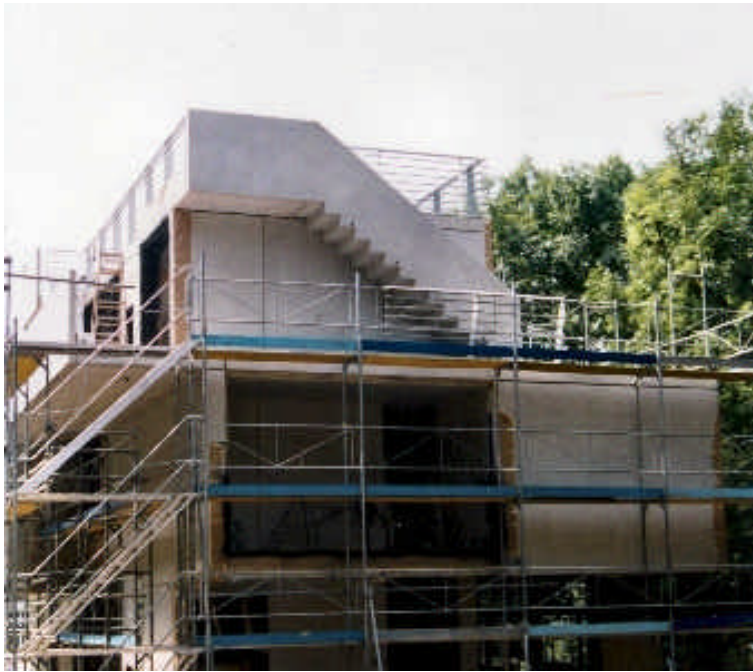
Das Stadthaus im Bau.
