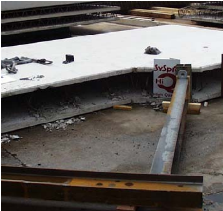
Bild 12: Einbauprüfung für Schrägzug
