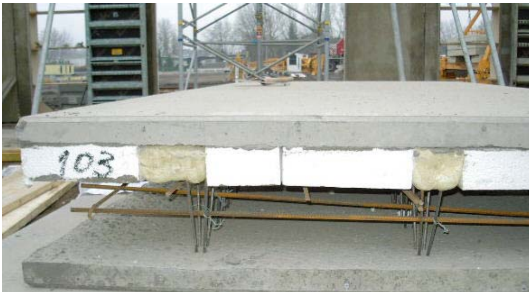
BILD 3: Fassadenplatten des Fallbeispiels
