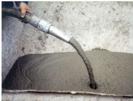
Ein Reduzierstück von 120 mm auf 80 mm Außendurchmesser erleichtert den Verfüllvorgang. Foto: Maxit
